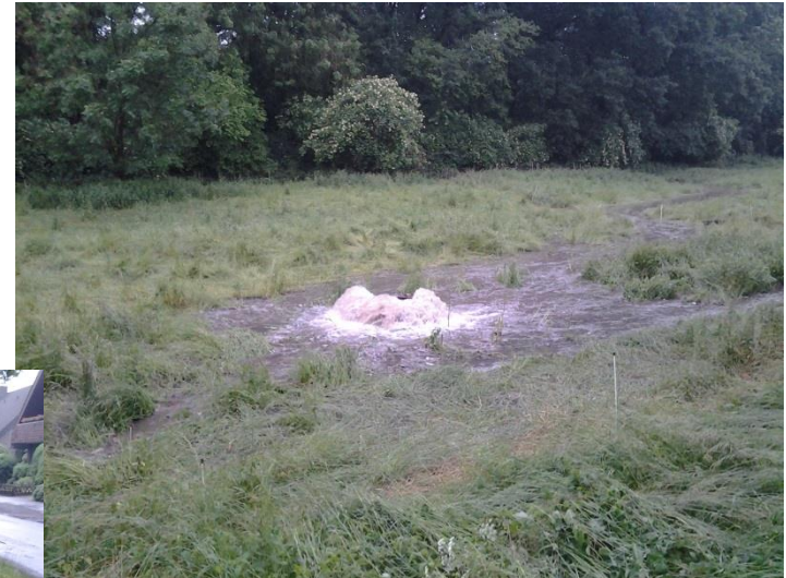
2016-05-30 10.27.25 Überstau SW-Kanal Frankfurter Str. vor KA Voerde
